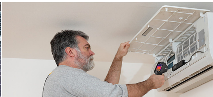
Inspection des conduites
