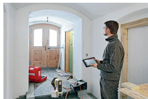
Opmeten deuropeningen en ramen
