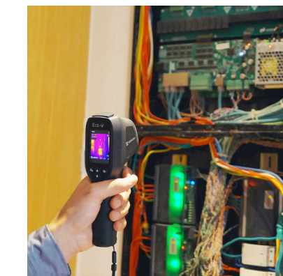
Controleren elektrische installatie
