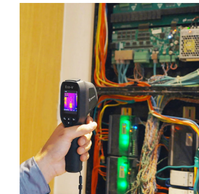
Controleren elektrische installatie
