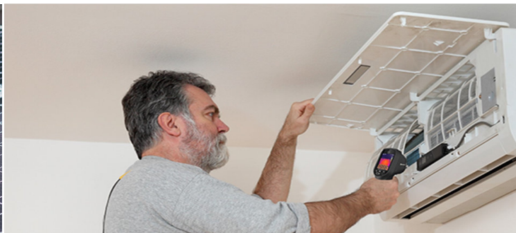
Inspection des conduites
