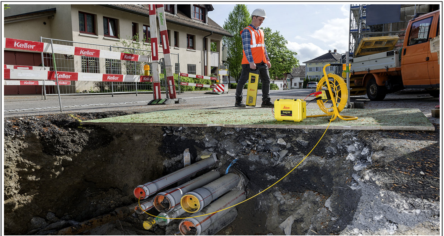
Localisation des conduites en PVC et des canalisations en béton à l'aide du générateur de signal DA et de la Trace Rod
