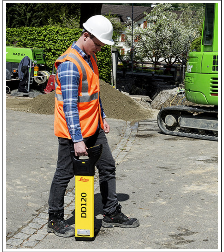
Localisation des câbles et des conduites
