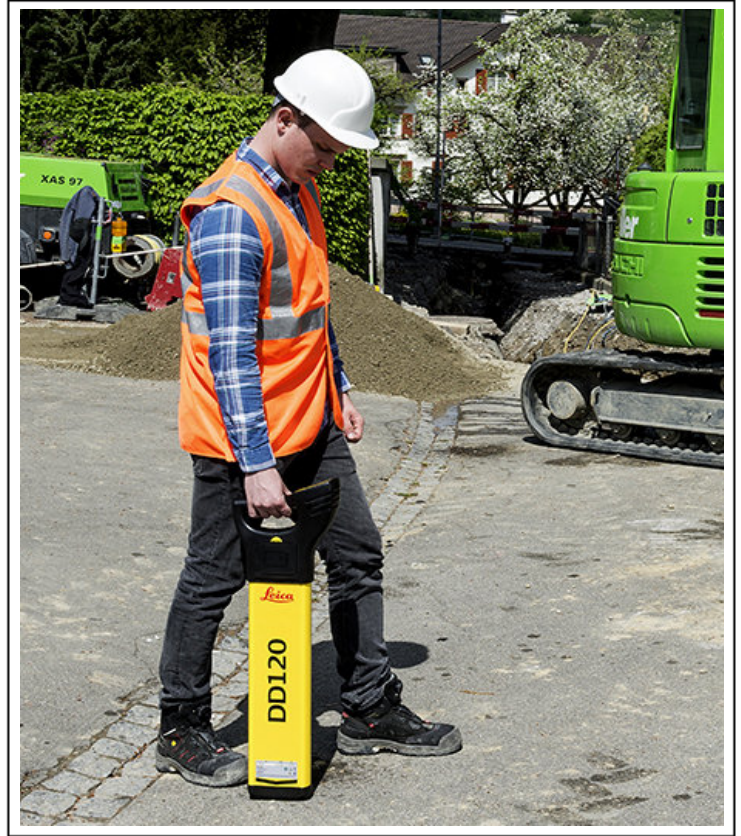
Kabels en leidingen lokaliseren
