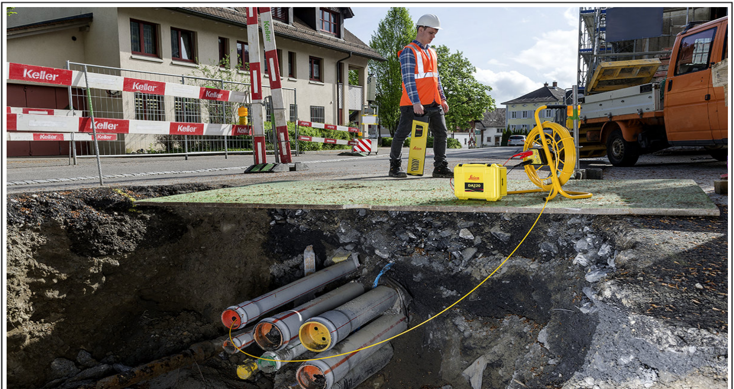
PVC buizen & beton buizen lokaliseren met DA signaal generator en trace rod
