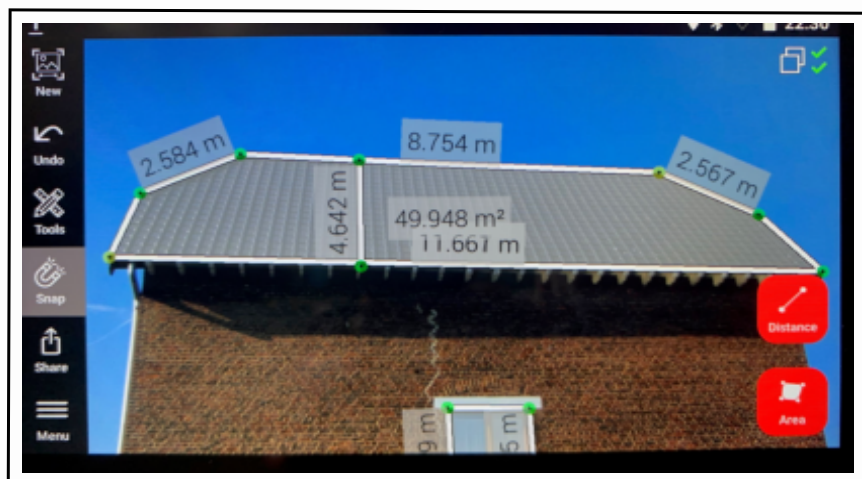
Mesure de toiture de bâtiment / longueur / largeur / hauteur / surface
