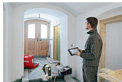
Mesure des portes et des fenêtres
