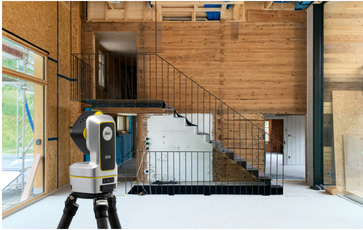
Mesure d'escaliers, de marches, de garde-corps, de sols...
