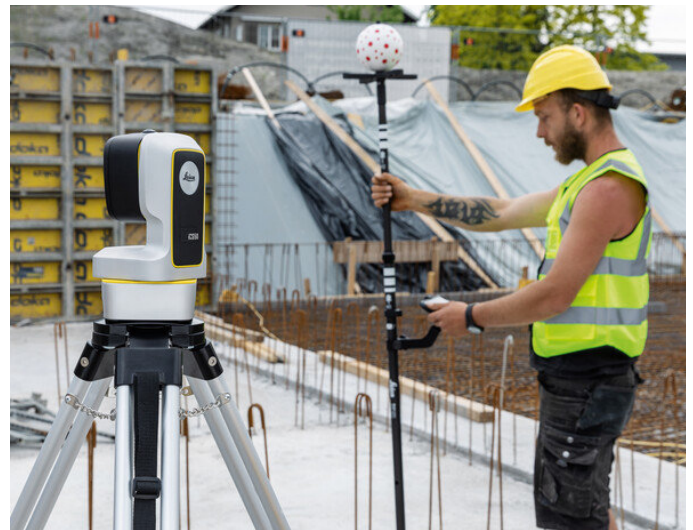
Mesure et implantation avec la Leica V Pole
